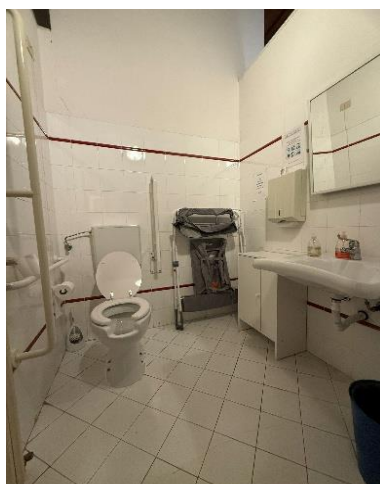
37 servizio igienico interno
